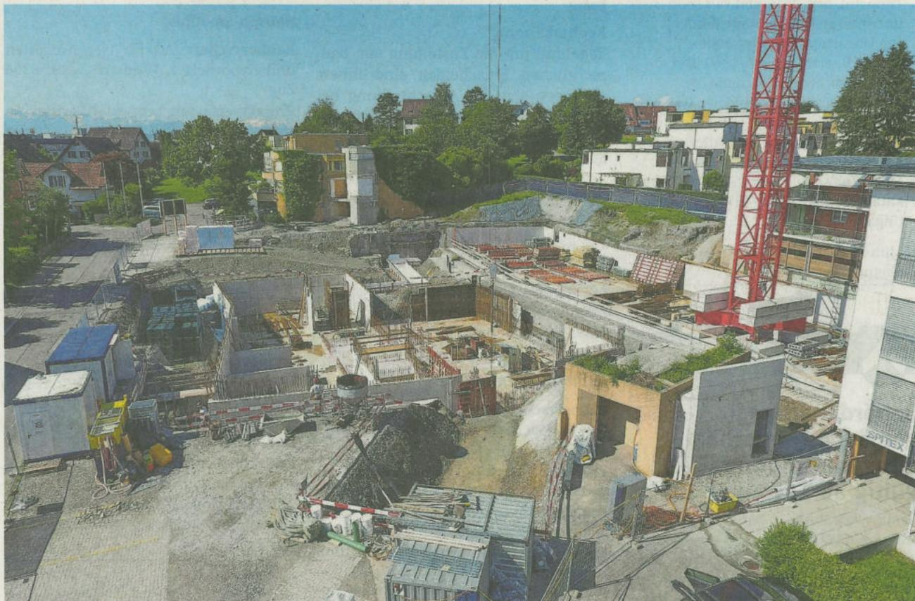
Vergangene Woche wurden die Aussenwände und ein Teil der Innenwände des Untergeschosses betoniert. (Bild Stefan Felder)
