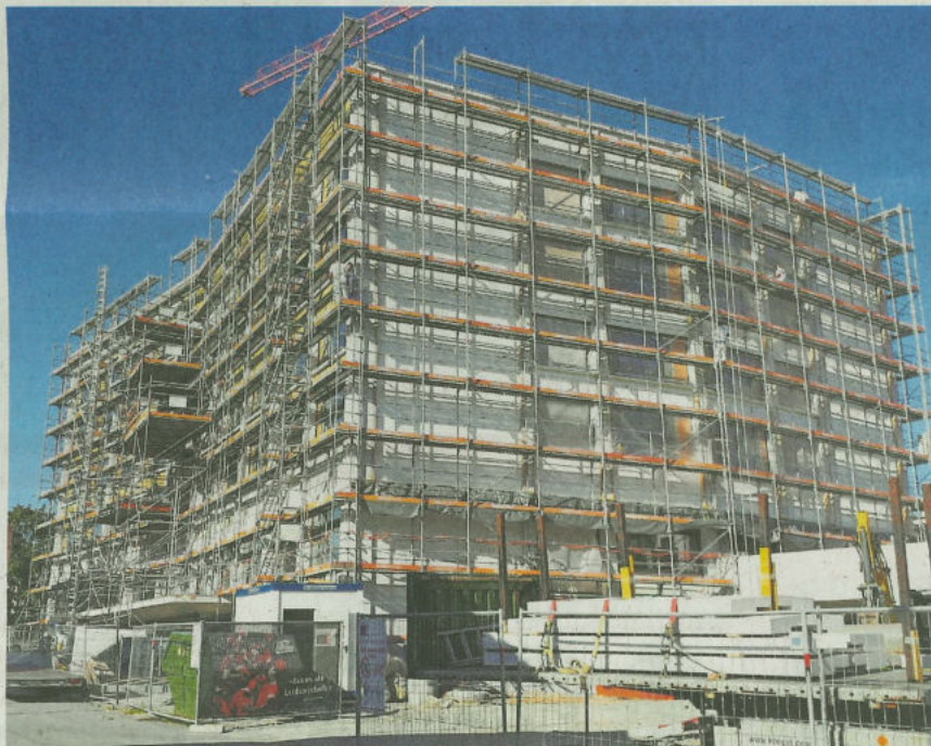
Die Baustelle Seewadel. (Bild zvg.)
