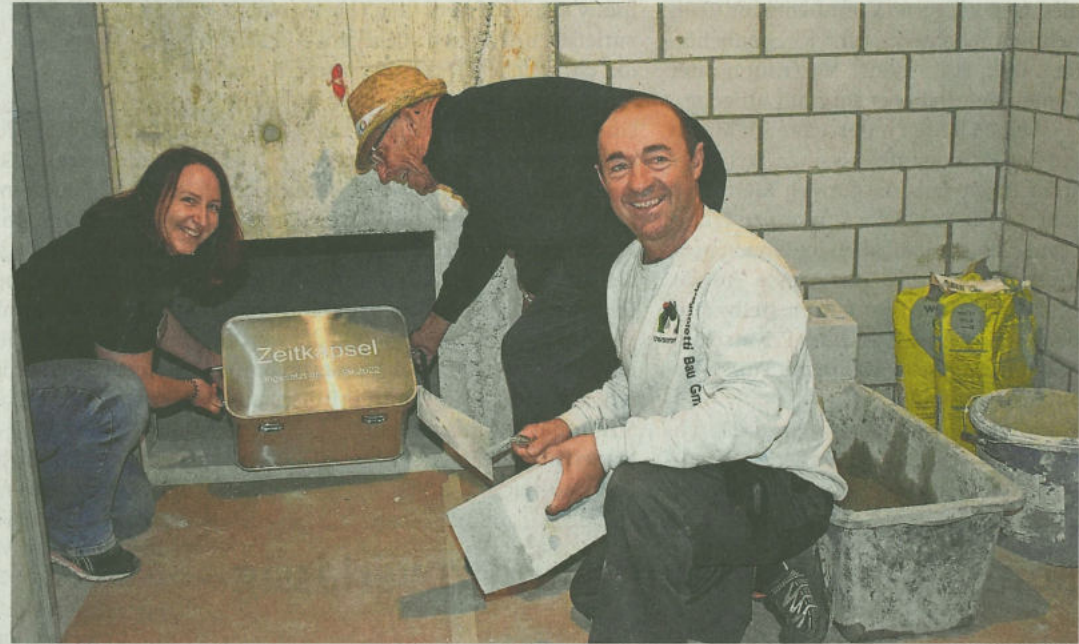
Patricia Keller und Bernhard Hess platzieren die Zeitkapsel im Hohlraum unter der Treppe. Maurer Giancarlo Pasquarelli ist bereit, das Loch zuzumauern.
